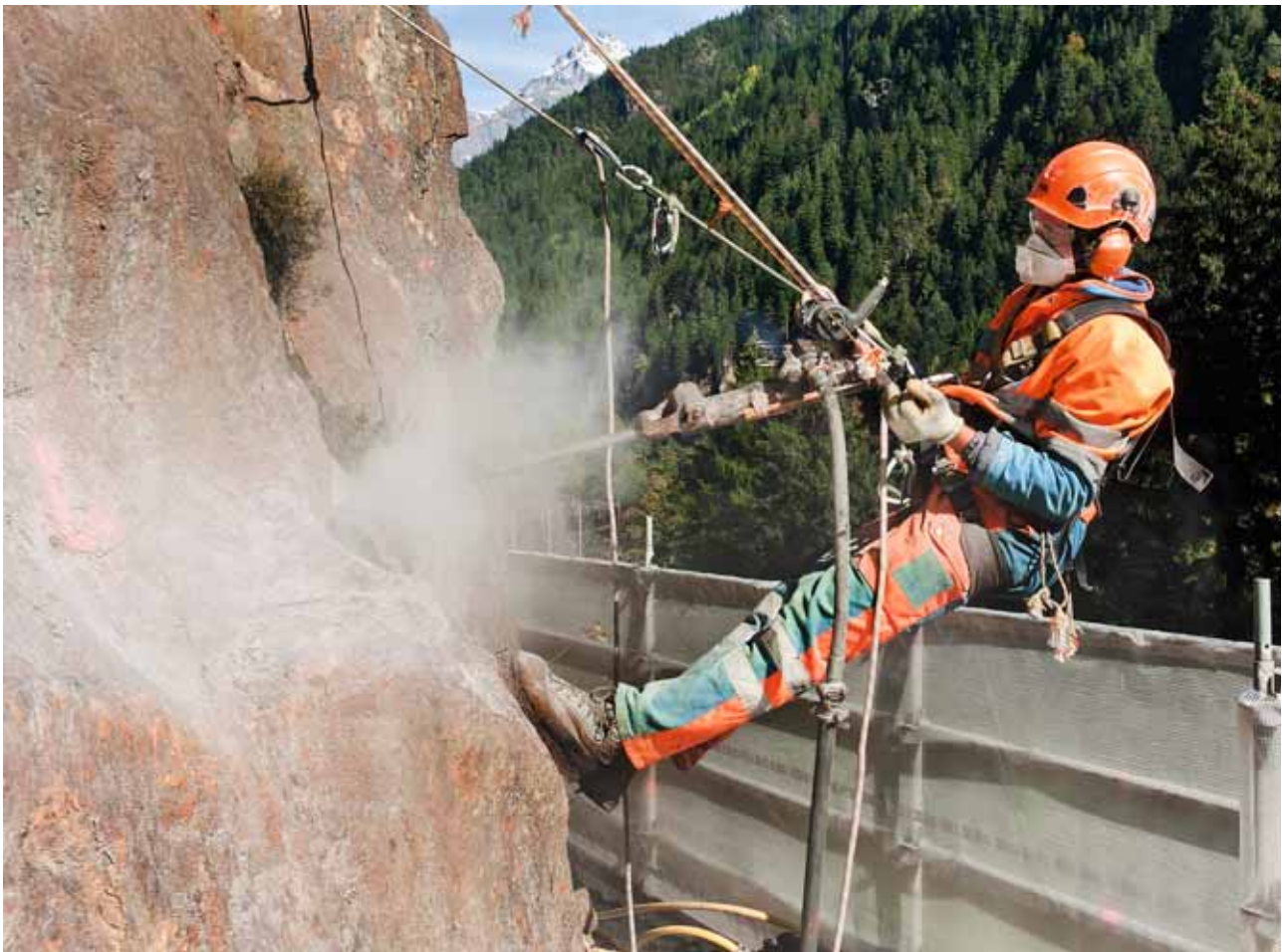
Foto 1 Le macchine portatili vibranti possono causare danni a mani e braccia.
