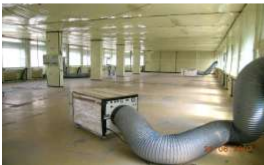
Allestimento area confinata per bonifica vinil-amianto
