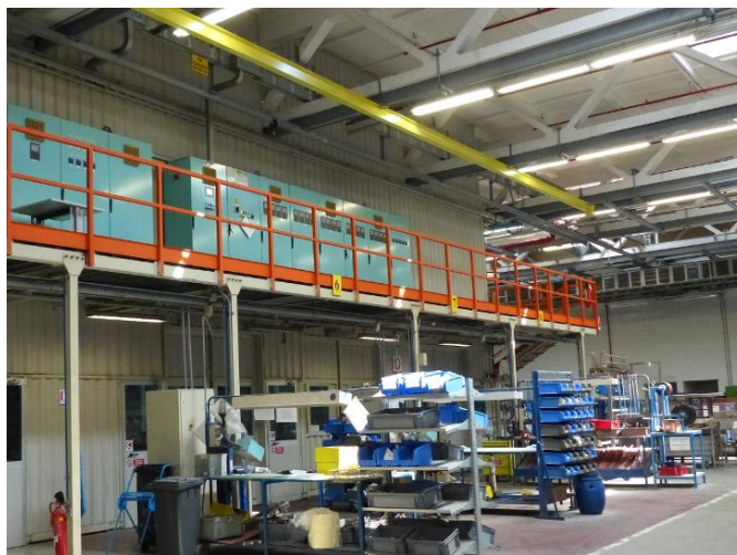
Figura 2. Tipologia di Soppalco (passerella) interno.
