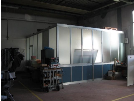
Foto 1: box composto da un'intelaiatura di profilati metallici e soffitto in pannelli di cartongesso
