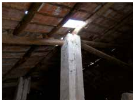
Sfondamento copertura non portante in fibrocemento ecologico
