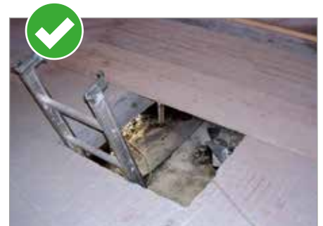
Scala sporgente e fissata alla base
