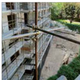
Ponteggio misto tubo giunto e portale
