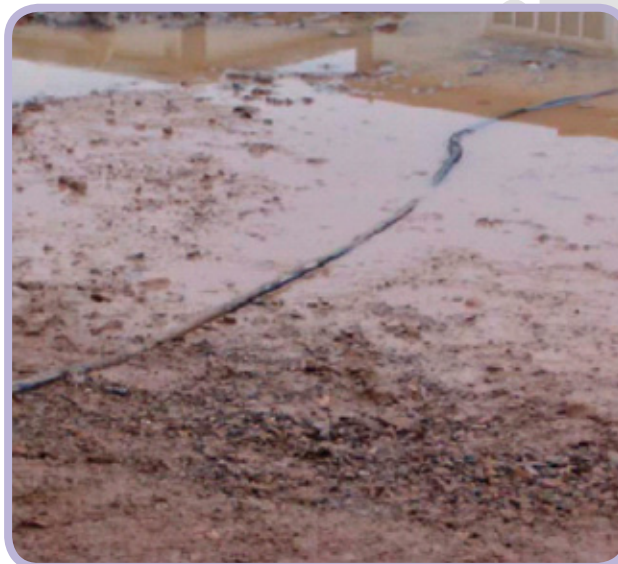
Figura 51: Cavo immerso nell'acqua.
