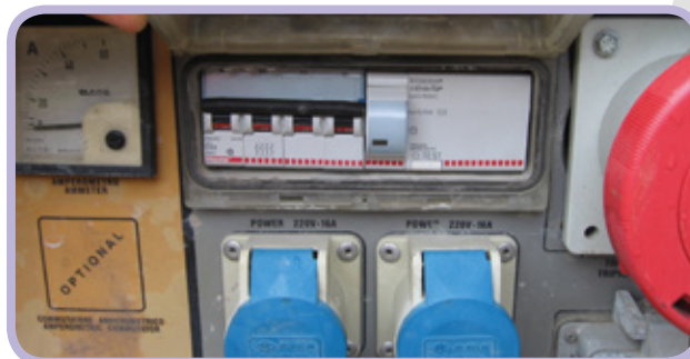
Figura 14: Interruttore differenziale da 30 mA.
