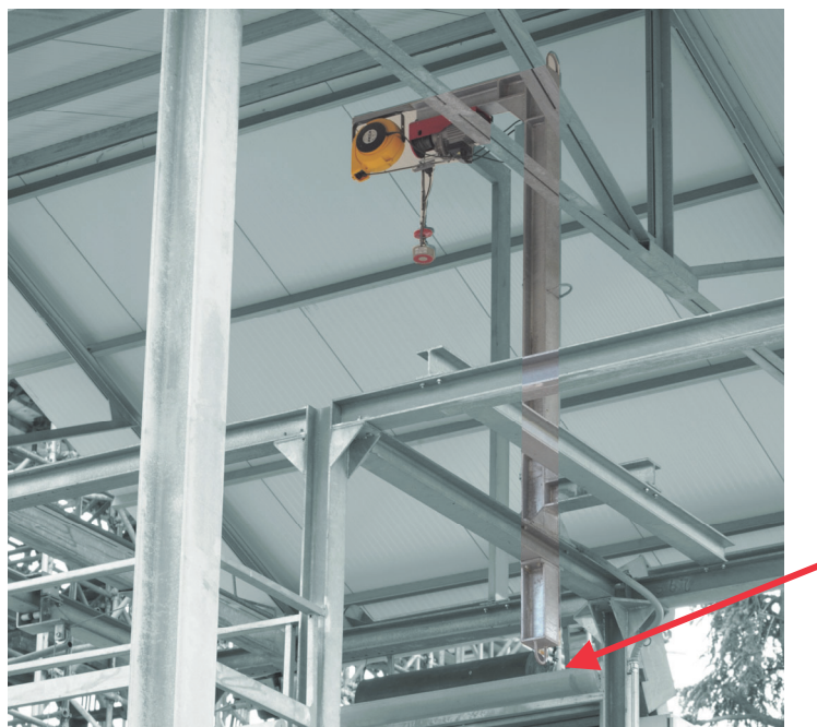
Figura 4.2.2.5-2 Attrezzatura di prova - particolare del punto di ancoraggio fisso
