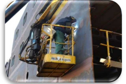
Lavori su piattaforme
