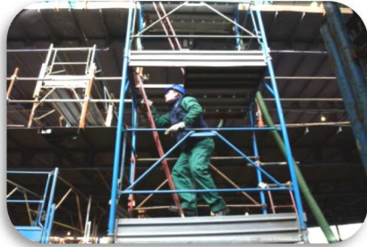
Lavori su ponteggi
