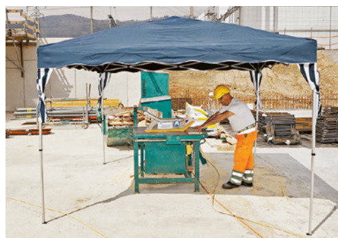
3 Se possibile, ombreggiare i luoghi di lavoro. Si tratta della protezione più efficace.
