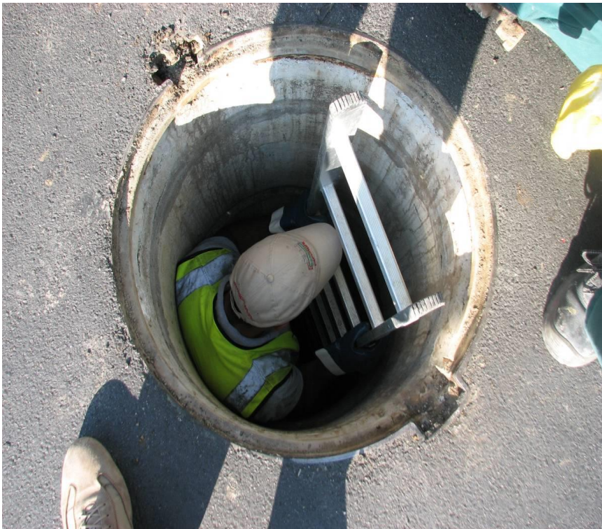
Fig. 1. Esempio reale. Un operatore scende in fogna di acque bianche per orientare una telecamera per video ispezioni. Risulta evidente la non sufficienza dell'allestimento sia per le dimensioni sia per l'impossibilità del recupero dell'infortunato (per gentile concessione di una degli autori).
