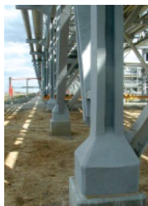
Fig. 4. – Strutture di acciaio protette dal fuoco in impianto petrolchimico
