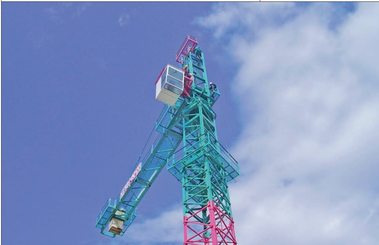
Lavoratori sul ballatoio del controbraccio in attesa dell'arrivo del braccio
