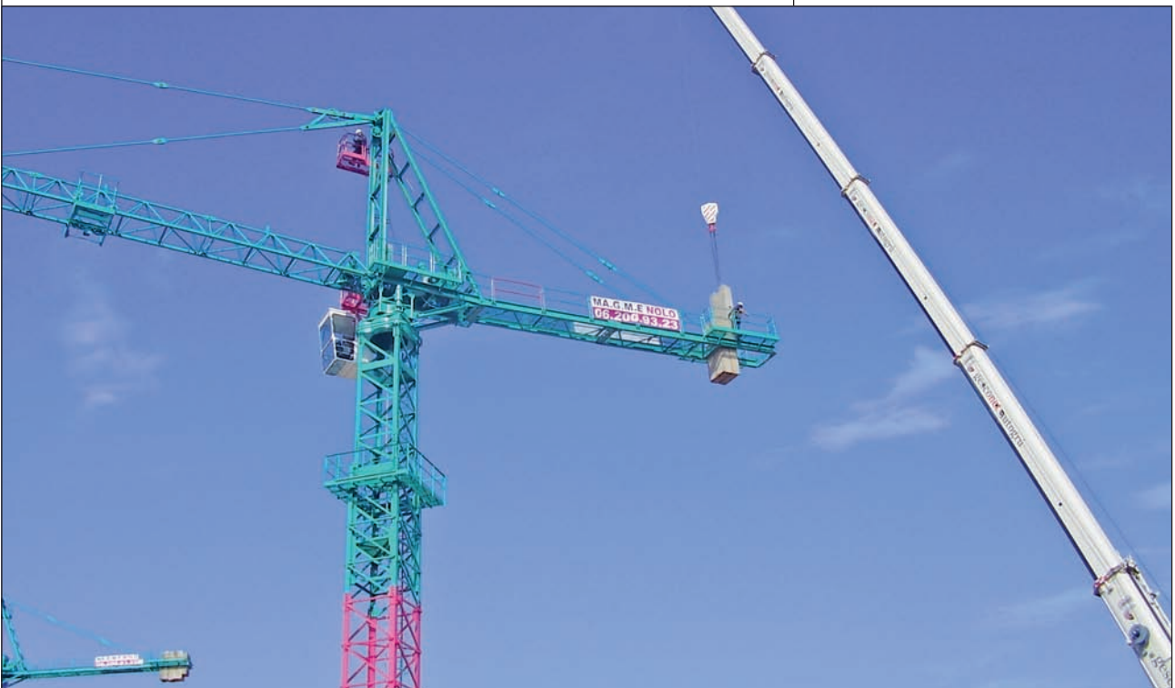
Ultima fase di montaggio: completamento della zavorra del controbraccio
