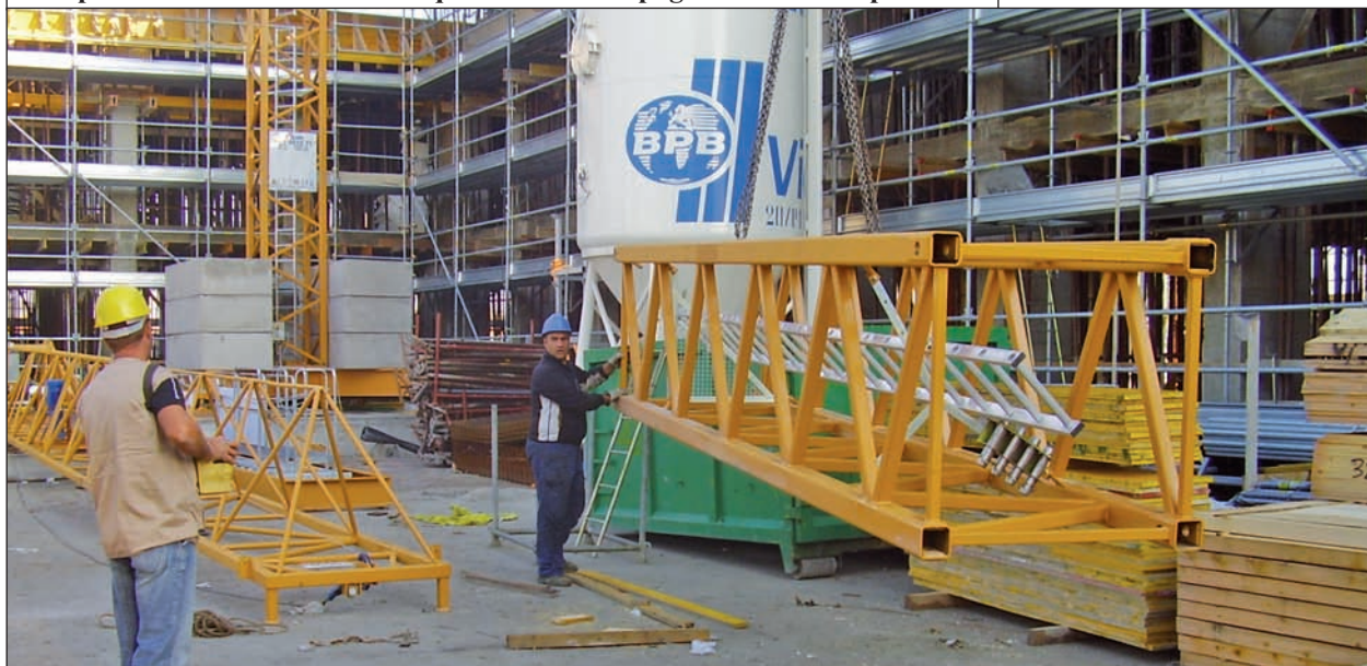
Trasporto dell'elemento a bassa quota con accompagnamento dell'operatore
