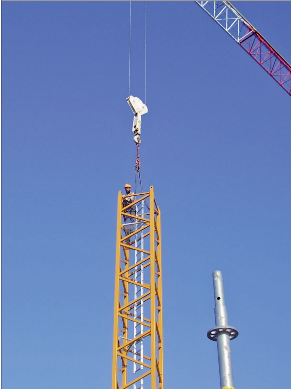
Montatore in piedi sul ballatoio di servizio che si accinge a liberare i ganci del sistema d'imbrago
