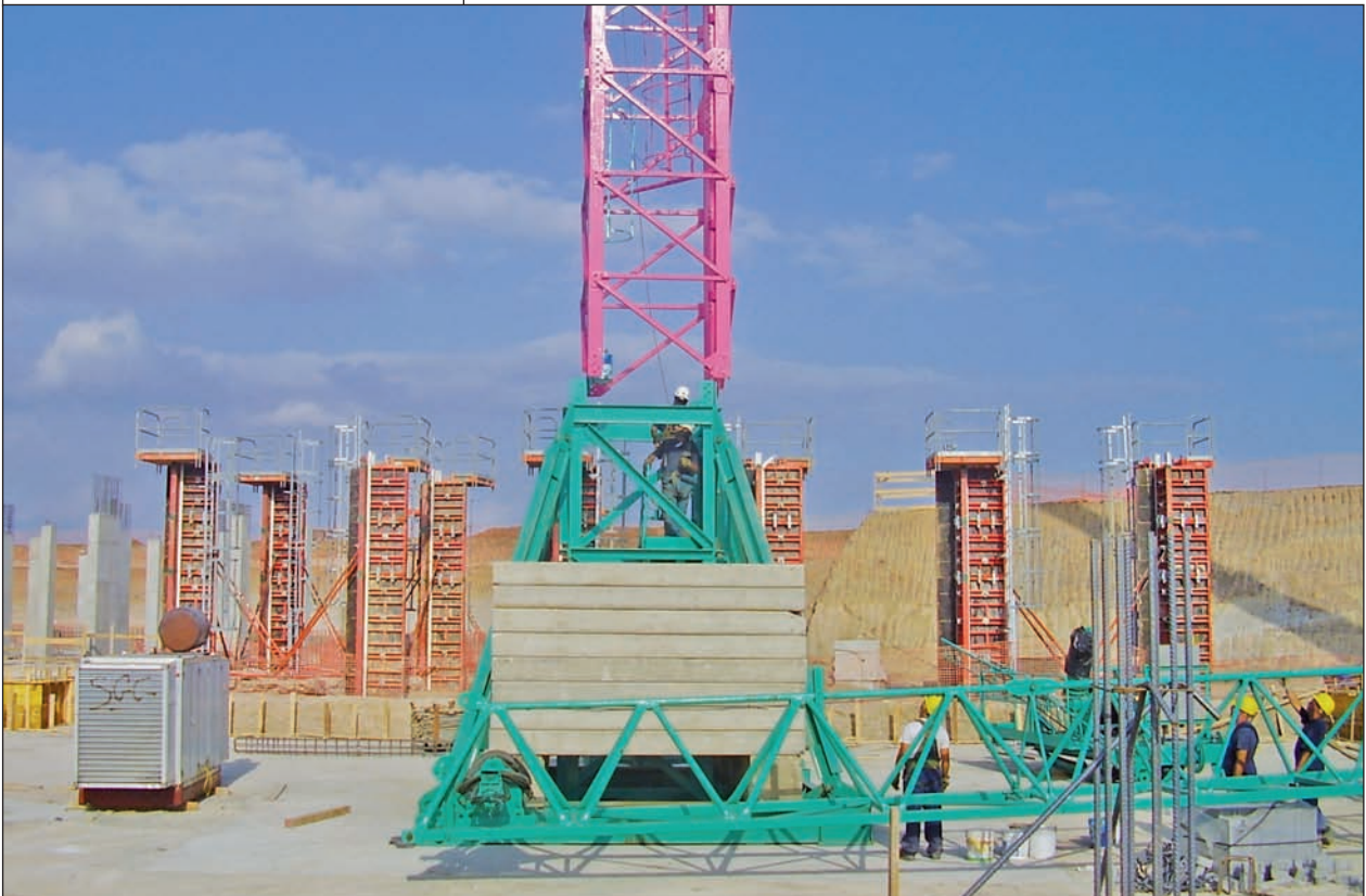
Presca del primo elemento di torre
