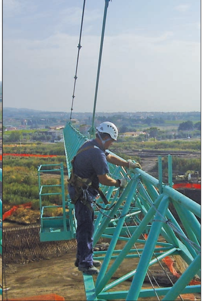
Ultima fase di montaggio: completamento della zavorra del controbraccio
