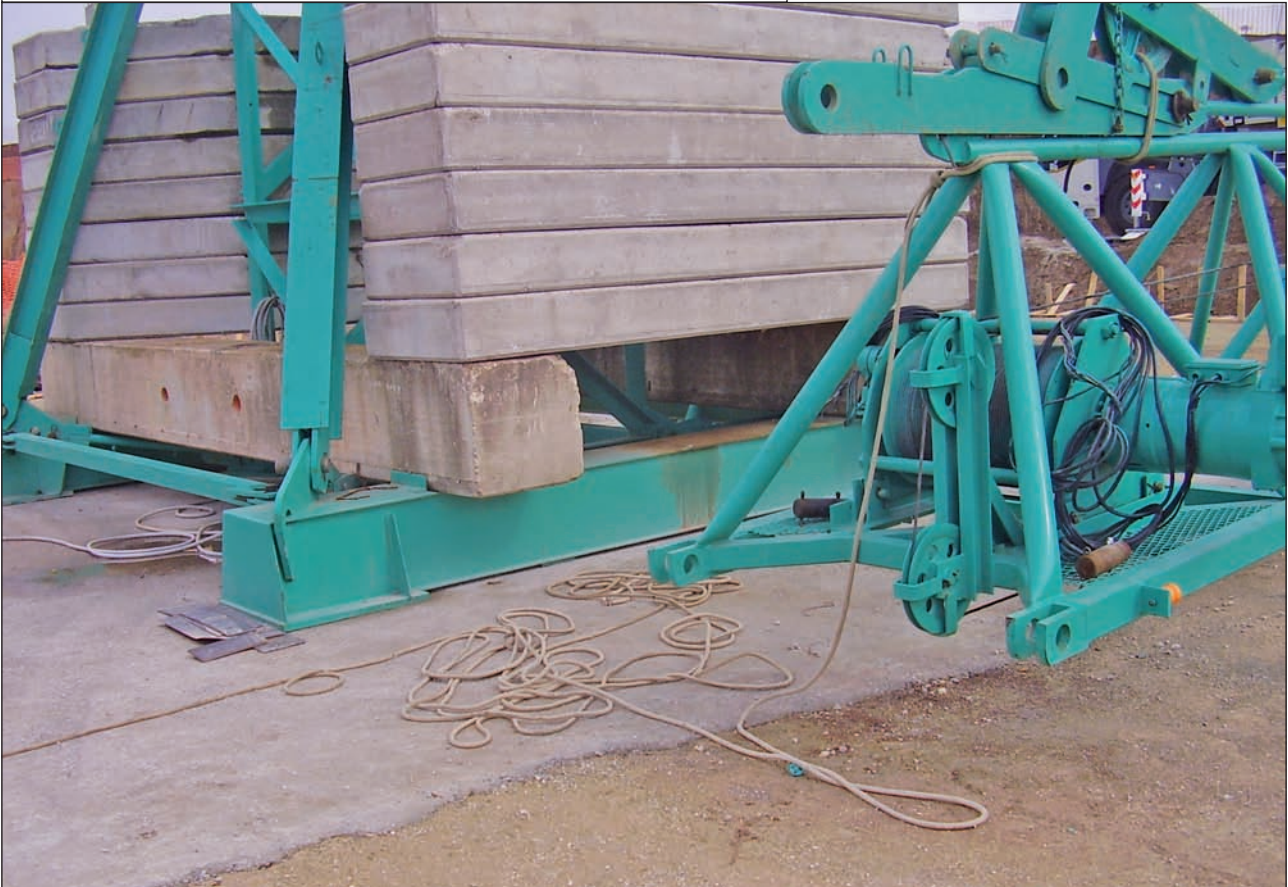
Fune di guida preparata a terra prima del sollevamento del braccio
