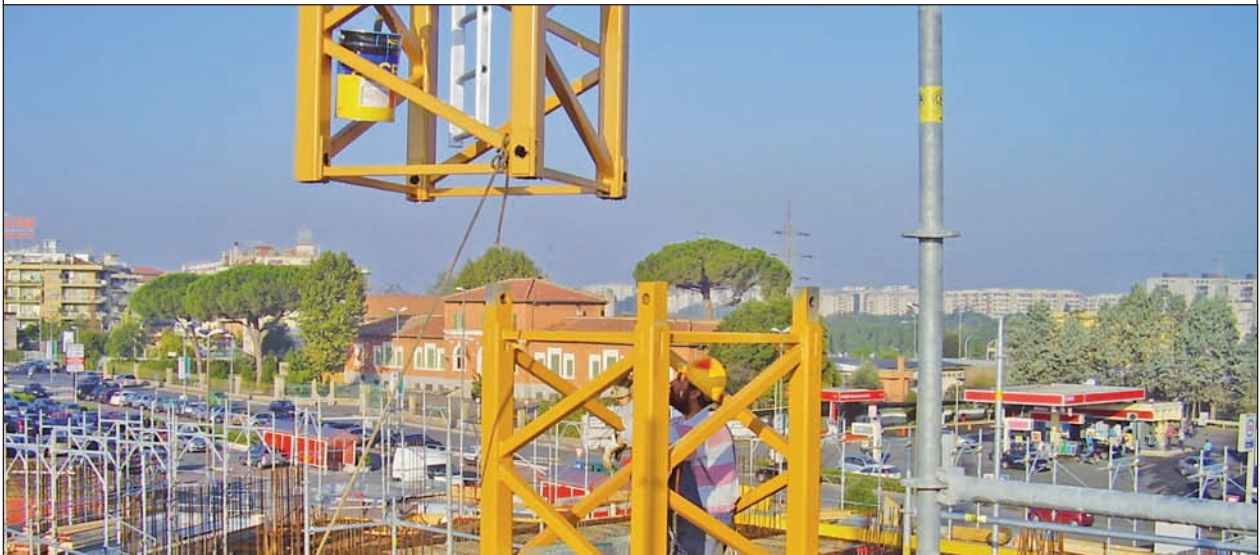
Montaggio di un elemento di torre: 2 - Montatore che afferra la base dell'elemento per gli ultimi spostamenti
