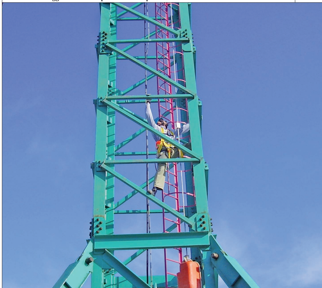
Linea di ancoraggio flessibile in posizione reale per risalire l'elemento e sistemare la scala interna
