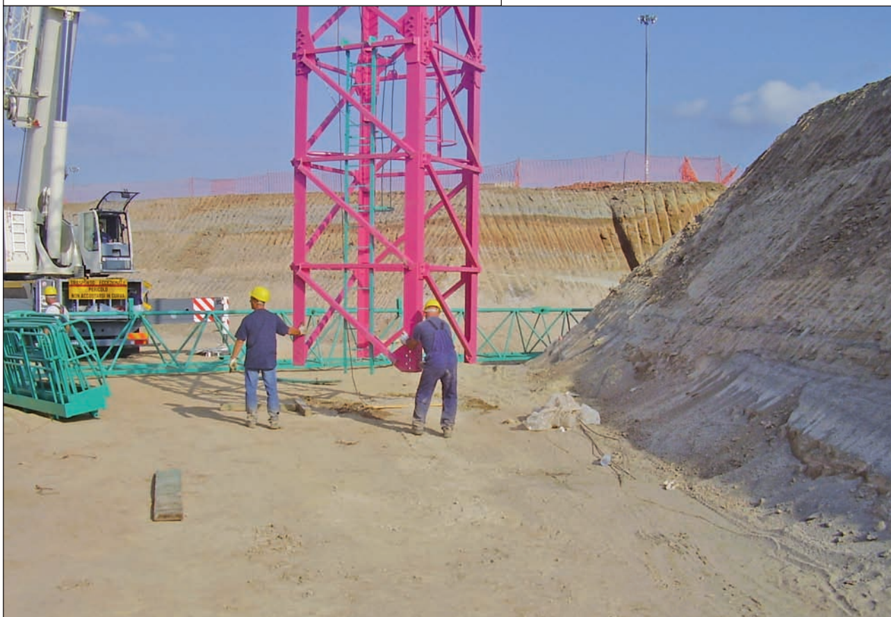
Prima fase di sollevamento: 3 - Stabilizzazione dell'elemento
