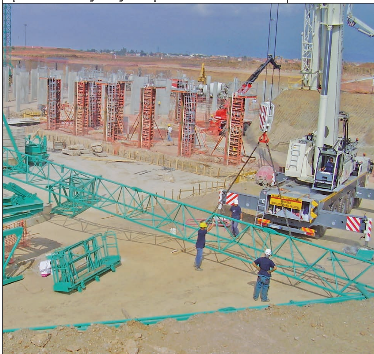
Operatore a terra che segnala al gruista di procedere al sollevamento del braccio
