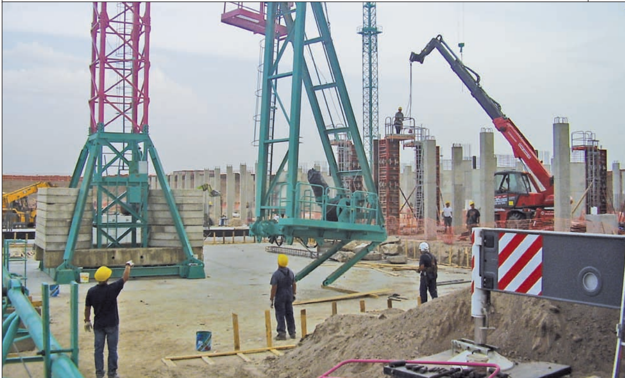
Sollevamento della cuspide – Sono visibili il ballatoio di servizio e la scala protetta per raggiungerlo
