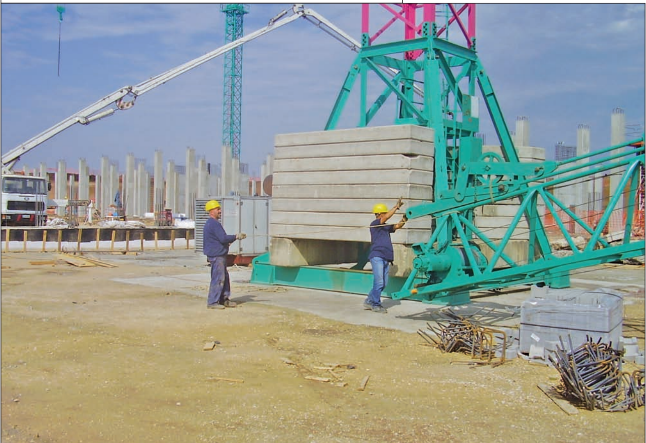
Prima fase del sollevamento da terra del braccio con fune di guida
