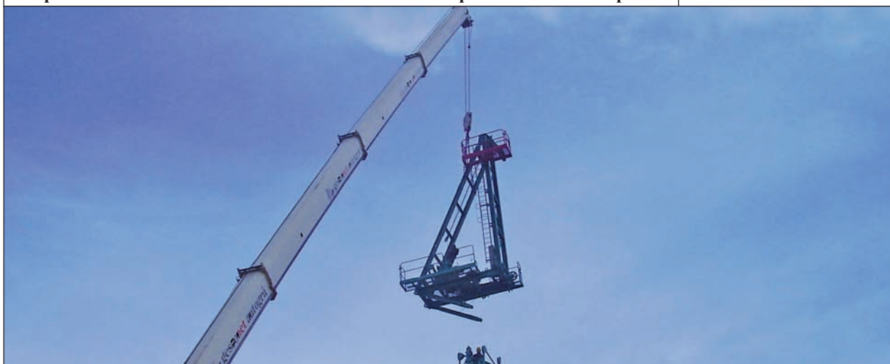
Cuspide. Sono visibili: Ballatoio inferiore - Scala verticale protetta-Ballatoio superiore
