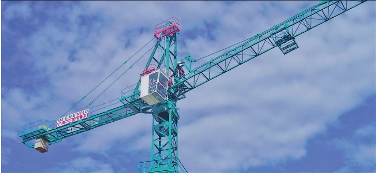
Sollevamento dei tiranti del braccio
