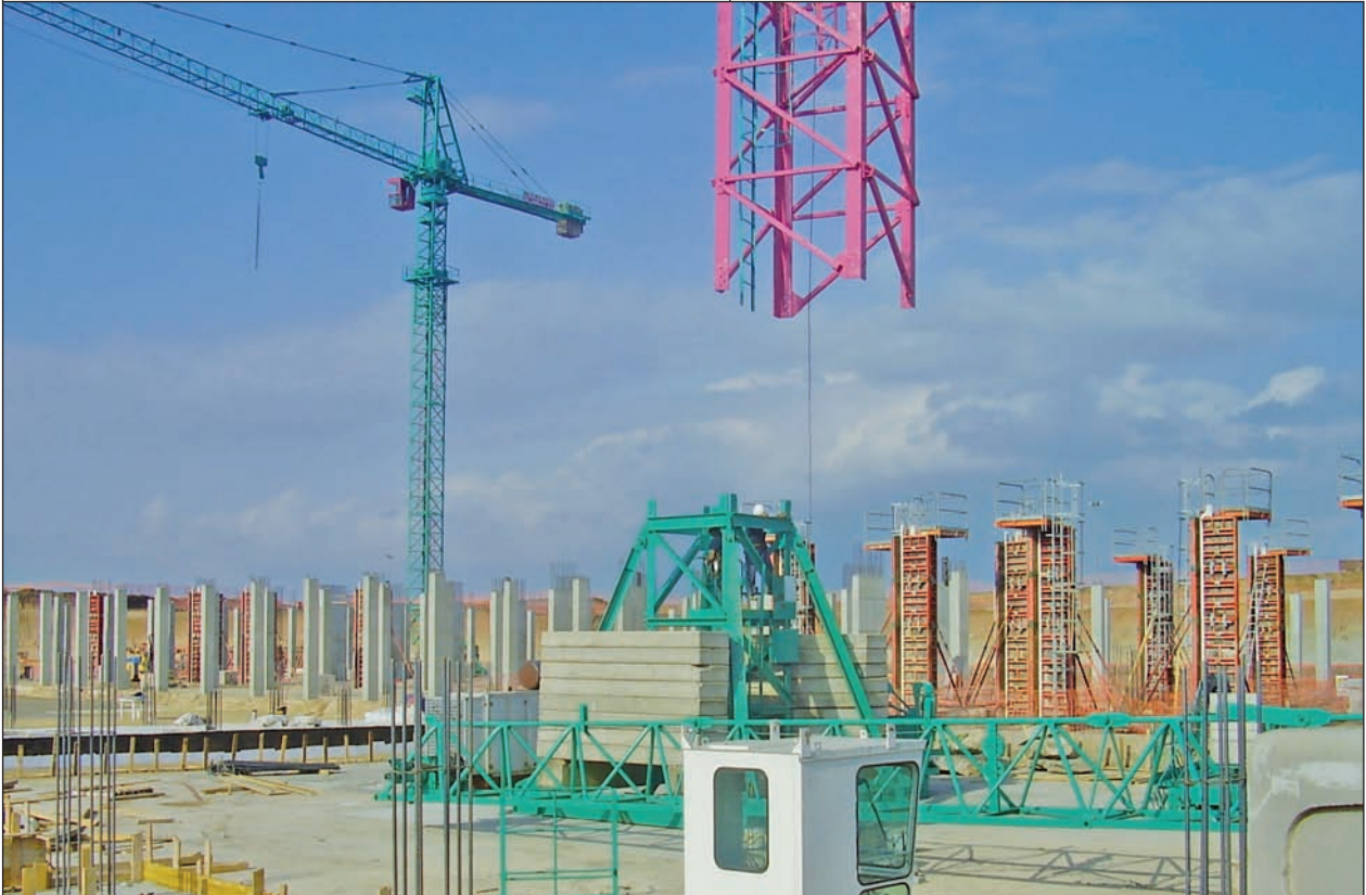
Trasporto guidato con fune del primo elemento di torre
