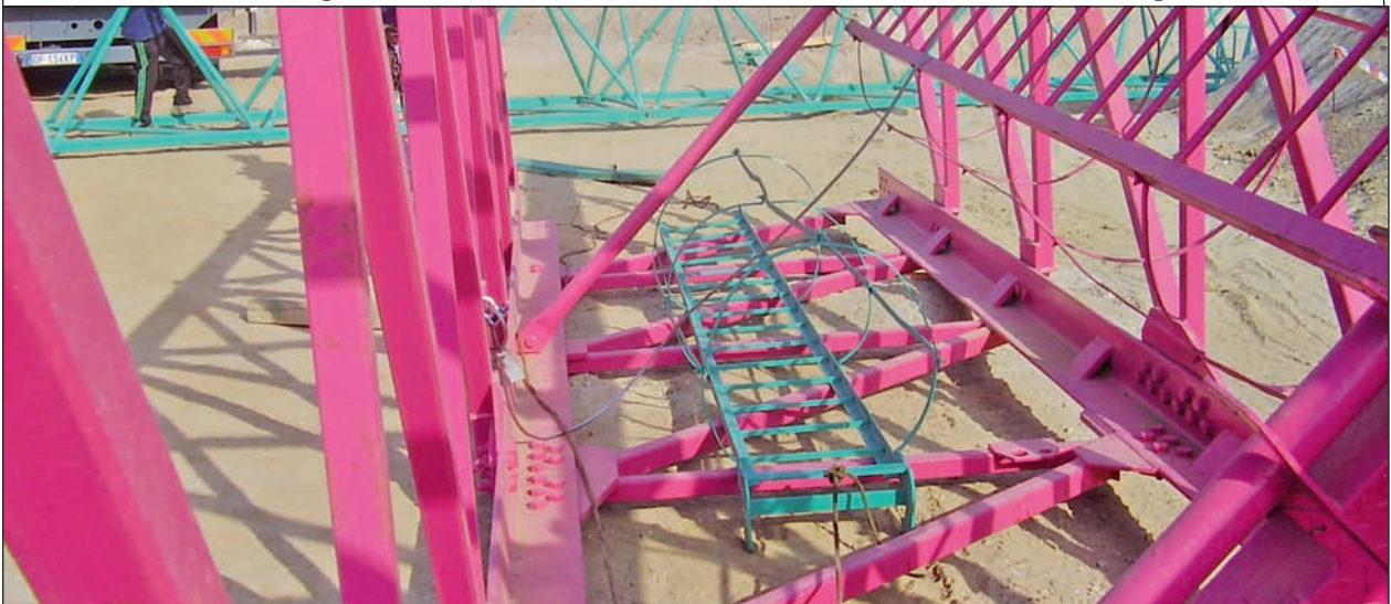
Elementi di torre ancora giacenti sul terreno. All'interno sono visibili le scale verticali sistemate provvisoriamente
