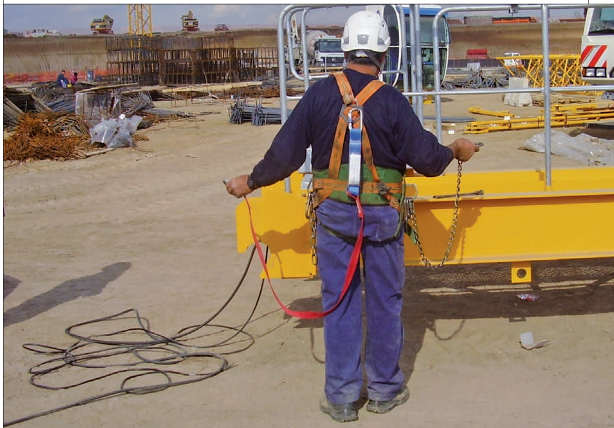
Montatore che indossa una imbracatura per il corpo con incorporata una cintura di posizionamento. E' visibile il cordino con dissipatore di energia e il cordino di posizionamento a maglie di catena
