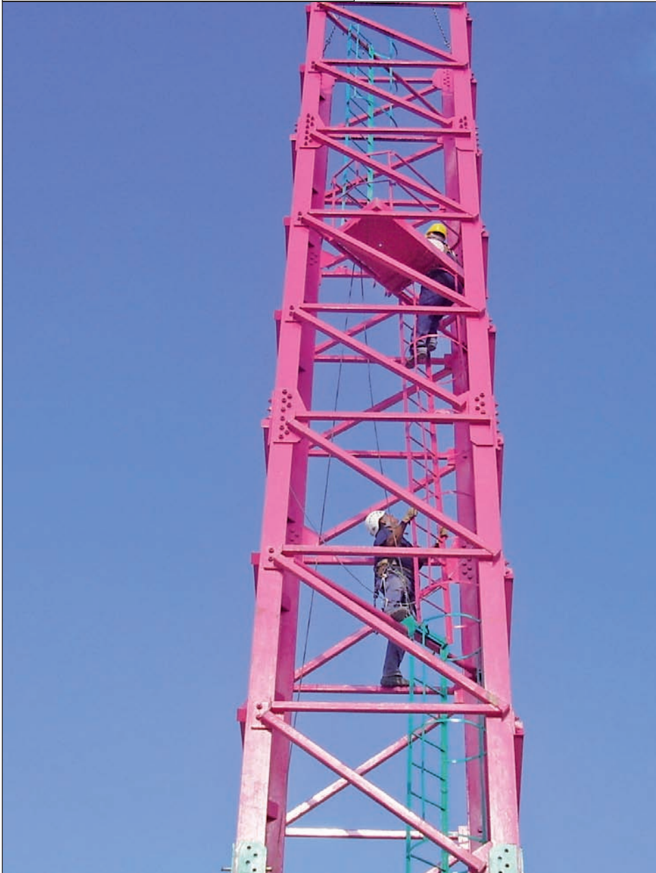
Risalita di un elemento dopo il montaggio
