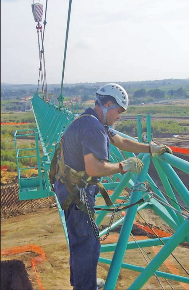
Ultima fase di montaggio: completamento della zavorra del controbraccio
