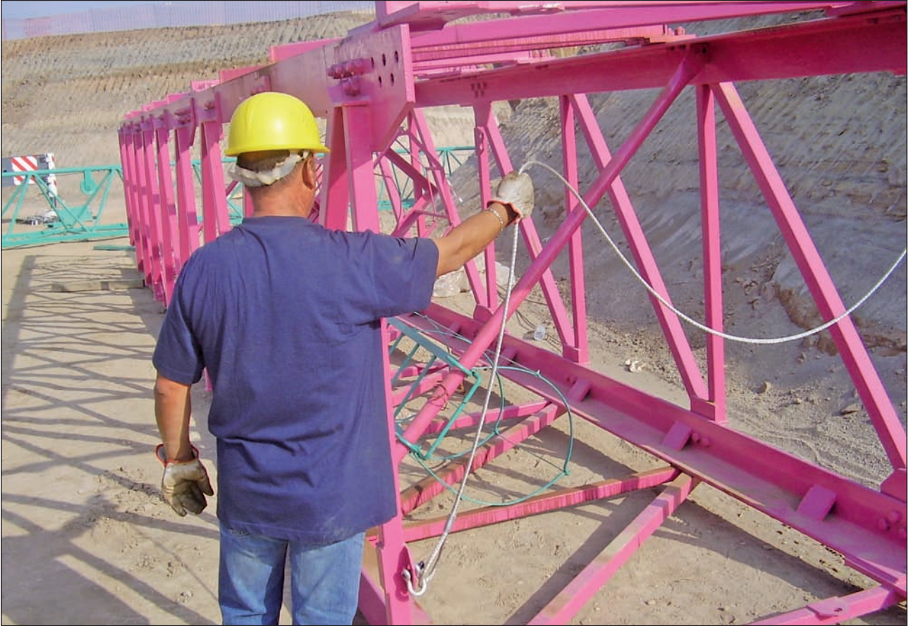
Fune di ausilio predisposta per l'ancoraggio dell'imbracatura durante la sistemazione in quota delle scale interne
