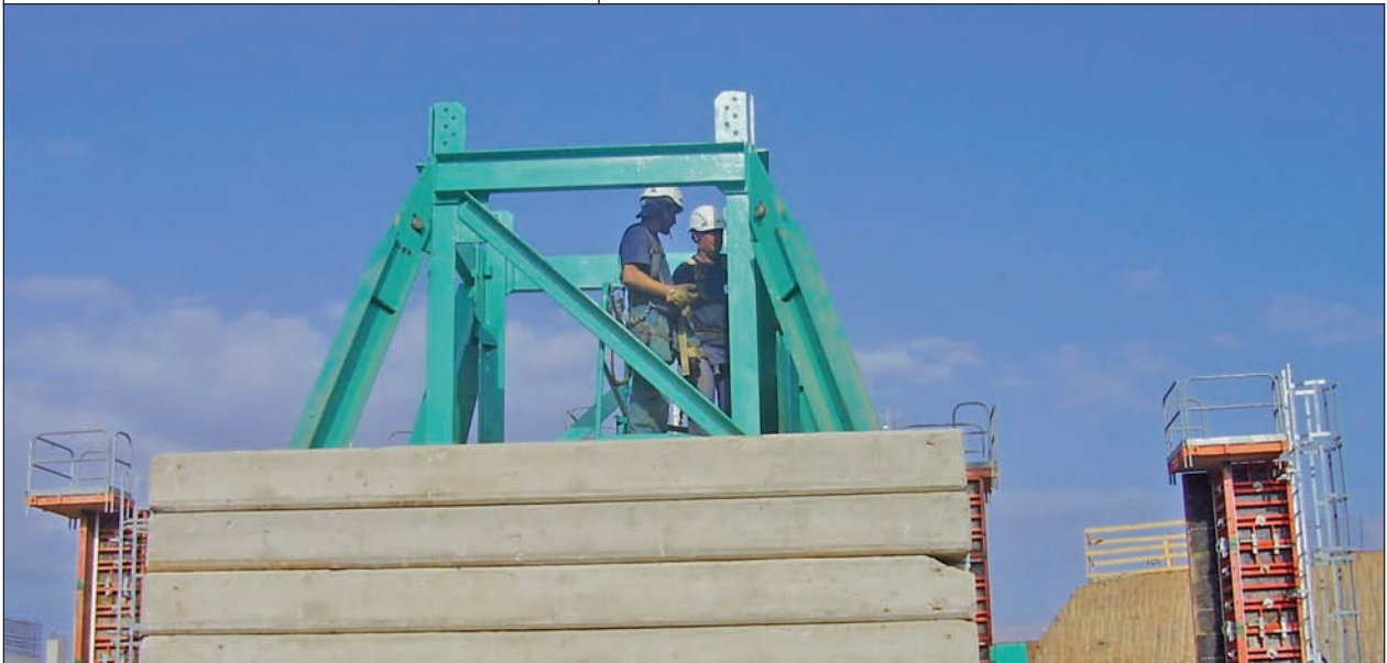
Operatori in attesa del primo elemento di torre
