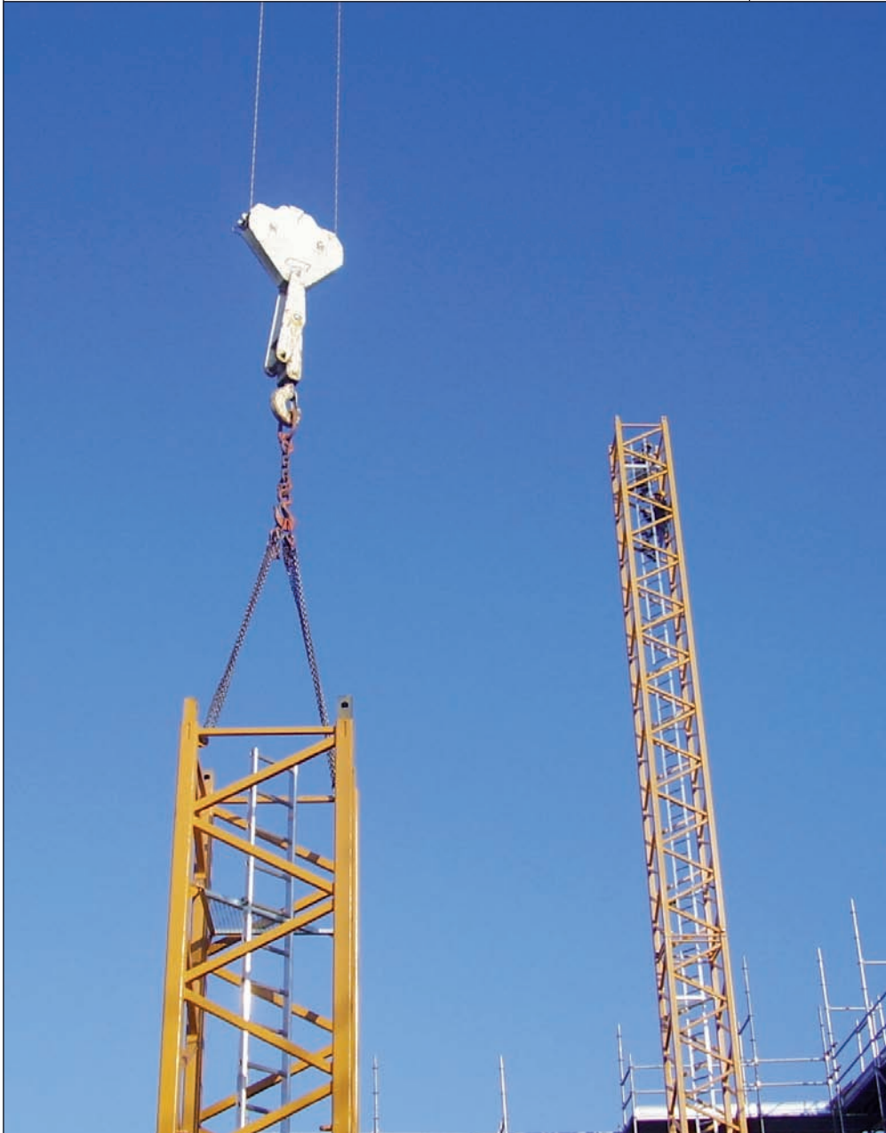
Lavoratori in quota (in alto a destra) in attesa dell'elemento imbracato
