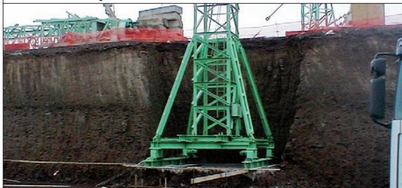
Gru ancorata a plinto di cemento armato - Carro di base senza zavorra
