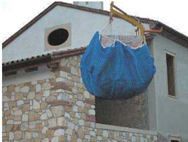
Fig. 2 – Presa di carico non unitario (senza pallet e involucro termoretraibile/reggette) con forca dotata di dispositivo di presa secondario (rete). Immagine tratta dalle linee guida Regione Lombardia.
