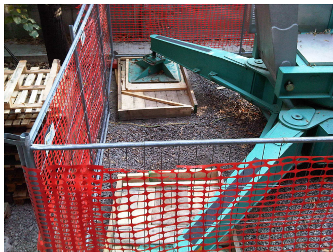
PIANO DI CAMPAGNA DEL CANTIERE (GHIAIA SUPERFICIALE), STABILIZZAZIONE CORRETTA
