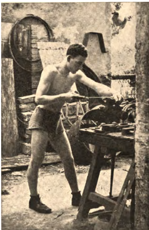
Limatore che fa un lavoro di grossatura
