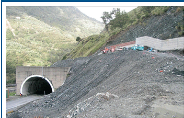
Figura 3 Realizzazione di una galleria in prossimità di un affioramento ofiolitico
