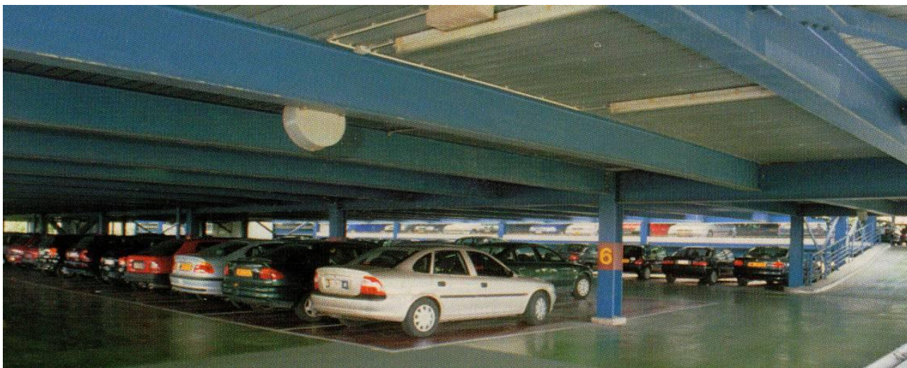
Fig. 3 – Interno di un edificio adibito ad autorimessa
